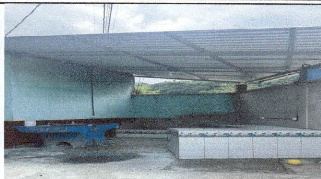
Foto 2: Sustitución de lamina troquelada y soporte de metal, sustitución de piso.
